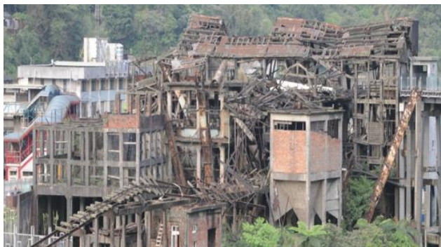
写真1: 修復前の「瑞三整煤廠」 (中国科技大学「新北市歴史建築瑞三礦業選煤廠修復規劃」より)
