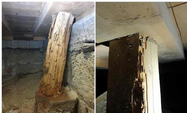
図6 朽みが生じている屋根部(金 2023 : P.217 図を改変)
