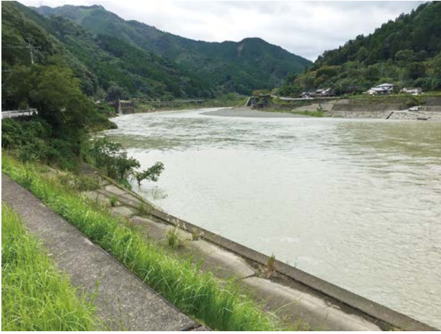
図3 荒瀬ダム撤去後の球磨川（2018年）（撮影：板垣）
