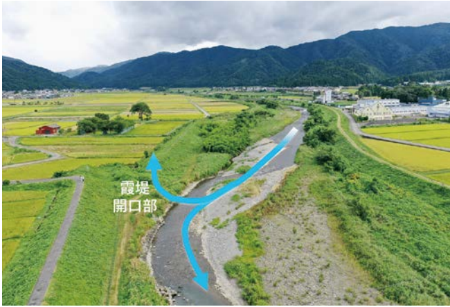
写真1 福井県北川流域に残る霞堤。洪水時には開口部から背後の水田に水がゆるやかに溢れる。撮影：一ノ瀬友博
