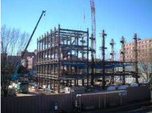
鉄骨建て方(2節)
