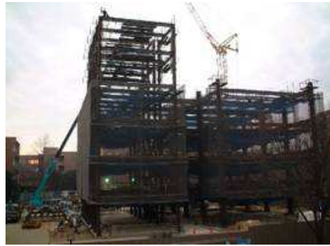
鉄骨建て方(3節)
