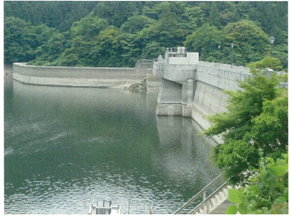
ダム湖・取水塔・洪水吐
