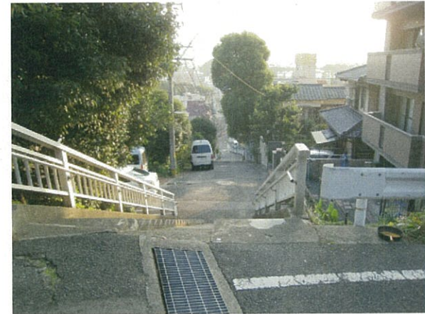
曲淵水源地からの導水路跡
