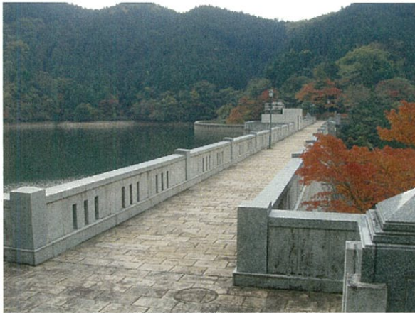
堤頂と遊歩道
