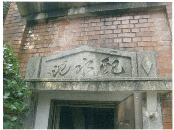
平尾浄水場配水池点検用入口建物
