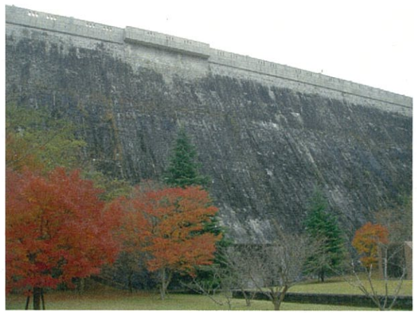
花崗岩練積と改良工事痕跡
