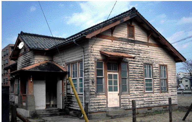
3 南西面外観（左玄関ポーチ）
