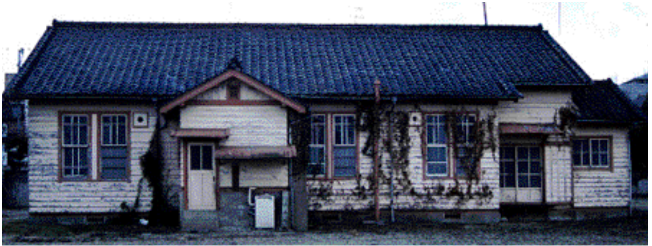
1 東面外観（左から寝室・浴室・子供部屋・書斎・使用人部屋・物置）
