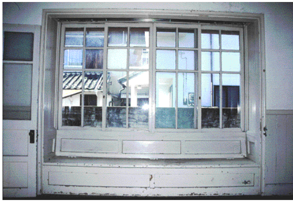
7 居間の腰掛け（物入れ兼用）付き出窓
