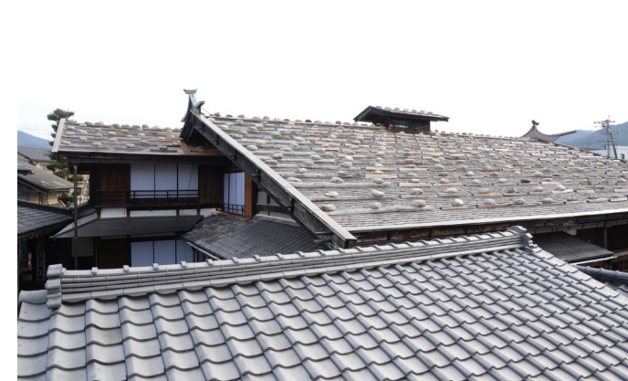
竣工 主屋屋根西面
