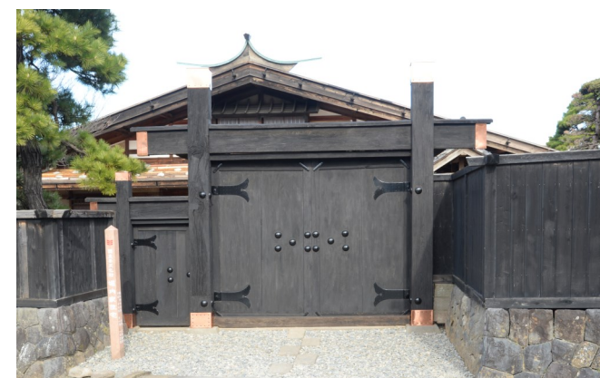
⑦附表門 柱補修、扉補修、金物補修、銅板包み取替等完了
