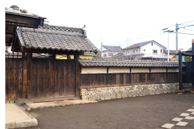
⑧上の門・東脇塀 瓦屋根葺替、木部補修、扉・一部壁面補修等完了
