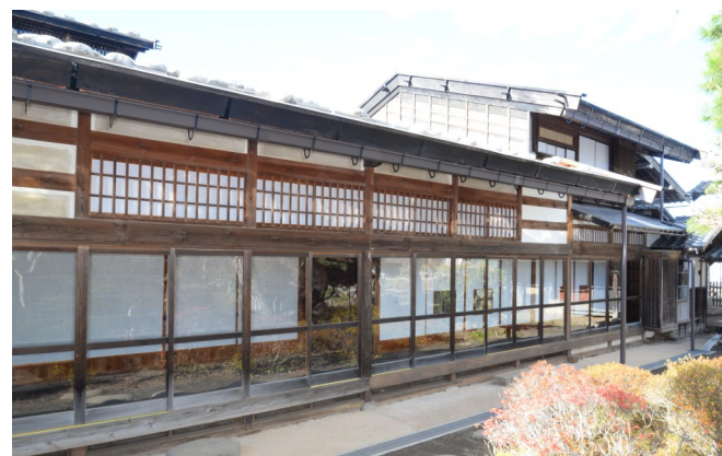
④主屋東面 柱取替、軒下廻り代用叩き、排水溝整備等完了
