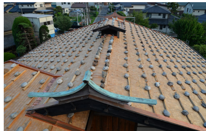
⑥主屋屋根 板屋根葺替、銅板包み取替等完了
