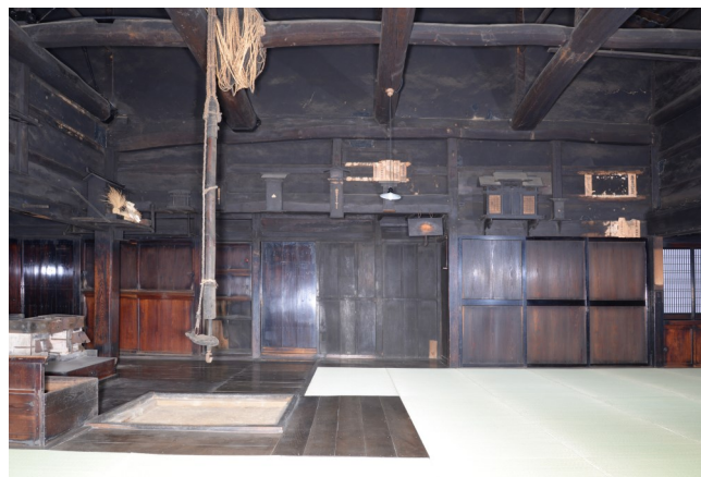
②主屋おえ 床組補修、壁面補修、囲炉裏整備補修、畳取替等完了
