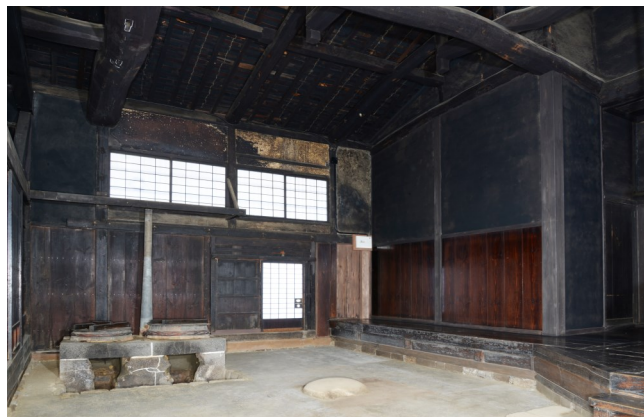
①主屋だいどこ 土間叩き、竈補修等完了
