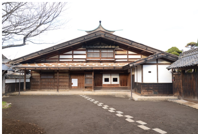
竣工 主屋南面
