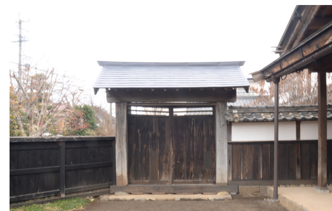
⑨下の門 金属板葺替、土台取替、扉補修、主屋続塀各部補修等完了
