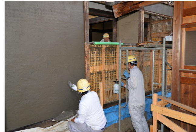
②荒壁塗 旧壁土と新しい土を混ぜた荒壁土を用いて復旧した。
