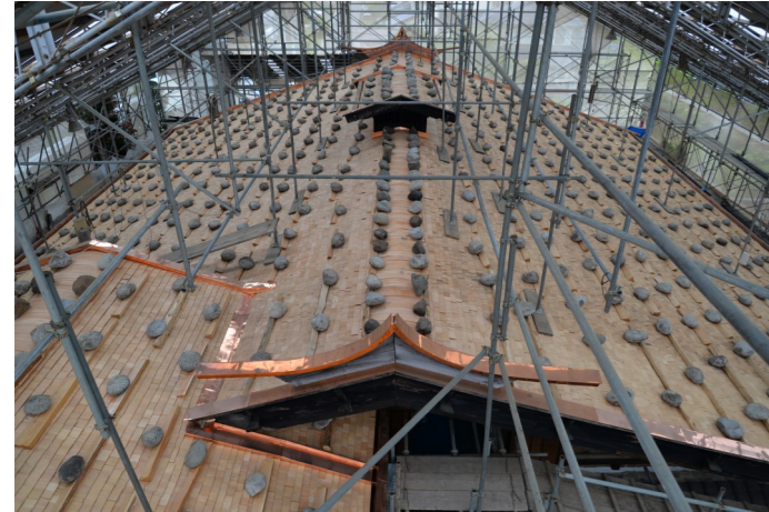
主屋屋根復旧状況 (H30. 6. 4撮影)
