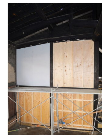
⑨だいどこ壁面構造補強
