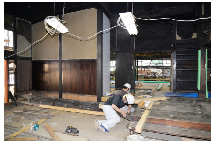
だいどこ廻り床組復旧状況 可能な限り古材を再利用して復旧する。
