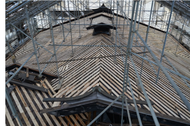
⑤屋根面構造補強 野地上部に構造補強のための斜材を取付けた。
