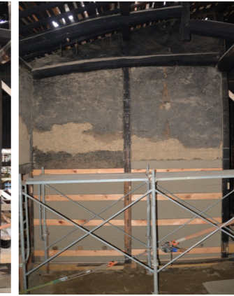
⑧だいどこ壁面補修
