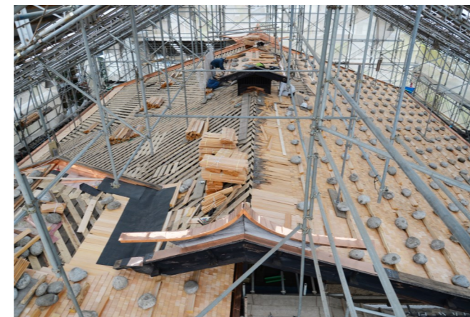
⑥屋根板葺施工状況 構造補強後、板葺旧工法に倣い復旧した。
