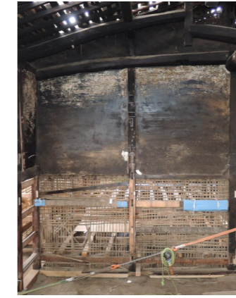
⑦だいどこ壁面解体前
