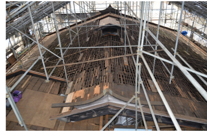
④屋根野地補修 破損した野地や垂木の補修を行った。
