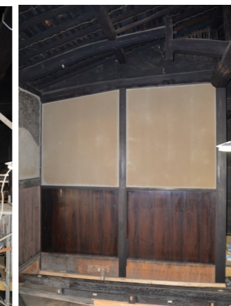
⑩だいどこ壁面復旧中
