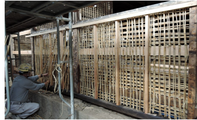
①小舞掻き 壁面の破損した葺を取替え、縄で編み込み復旧した。
