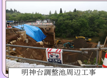
明神台調整池周辺工事
