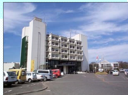
改修が必要な佐倉市本庁舎
