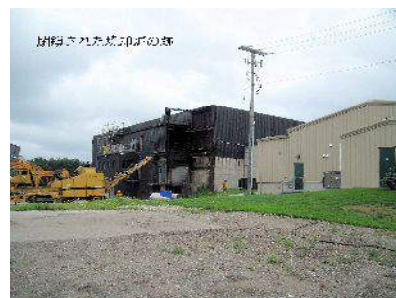
▲閉鎖された焼却炉の跡
