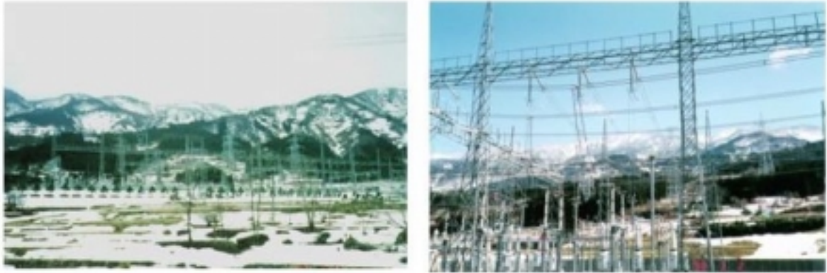
図 4.3.2 関西電力城端開閉所（富山県）
