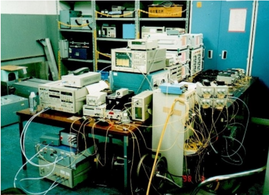
図 4.3.13 城端開閉所での送受信器の設置状況
