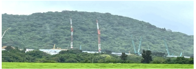
石垣の自衛隊基地建設現場（昨年3月撮影）
