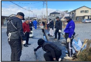
小磯聡弘様宅東の側溝蓋掛け
