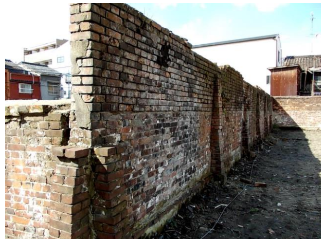
煉瓦塀の状況 (北東から)
