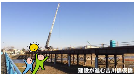
建設が進む吉川橋仮橋
