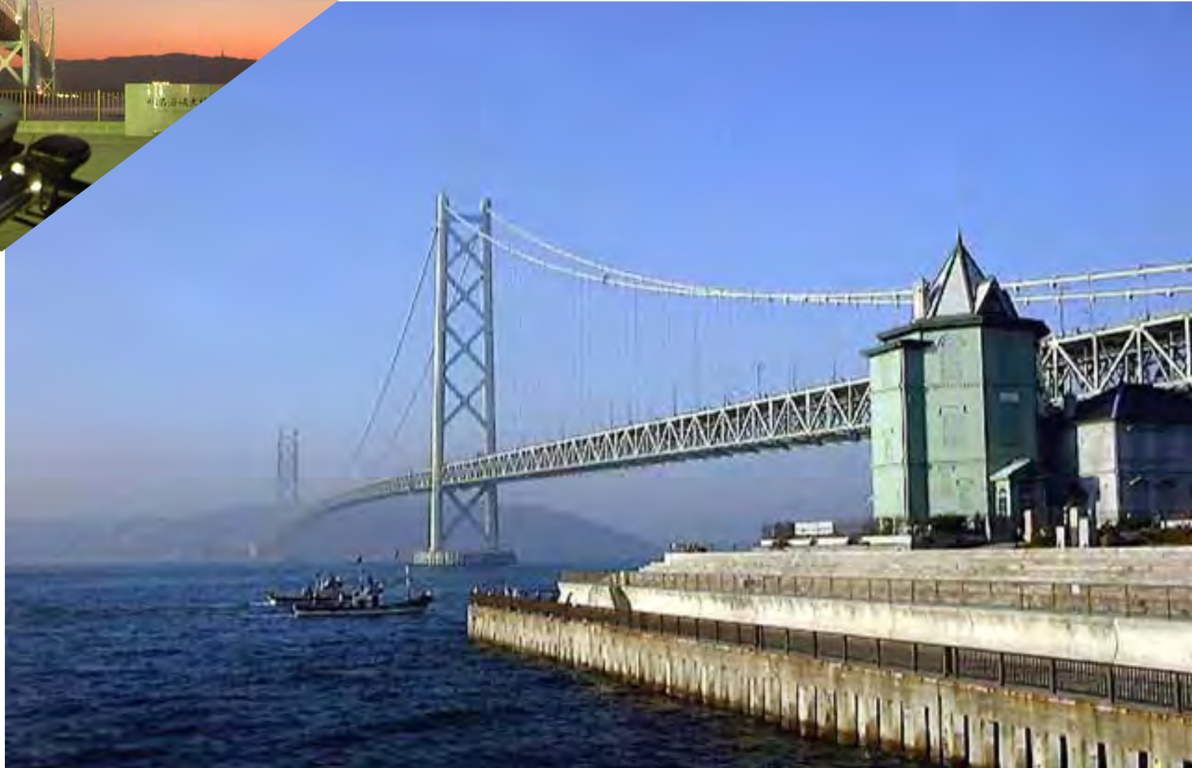
明石海峡大橋 全長3,911m、中央支間長1,991m、主塔の高さ293.3mの世界一のつり橋で、平成10年4月5日午後5時に開通
