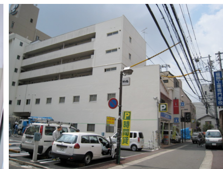
建物の外観(2008/3/31 撮影)
