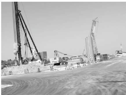
4月末、獣医学部の現場を見してきました。3月の今治市議会で決議が通ったばかりなのに、既に工事が進んでいました。
