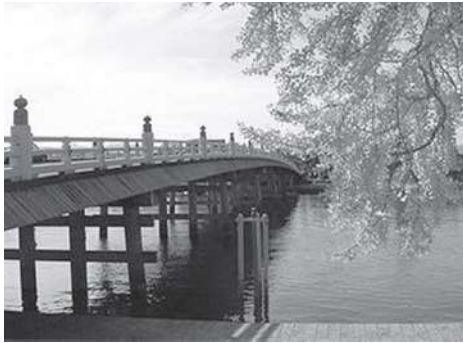
瀬田唐橋の架け替え工事 中井源左衛門
