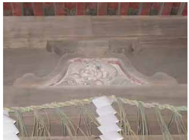
本殿正面髹股 (中)
