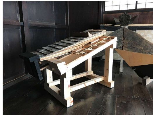
板葺き屋根の構造模型
