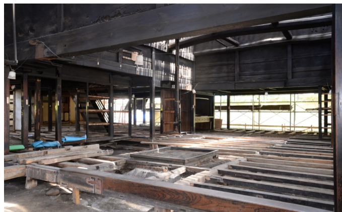
主屋は揚屋に先立ち、床板・板壁等を解体しました。
