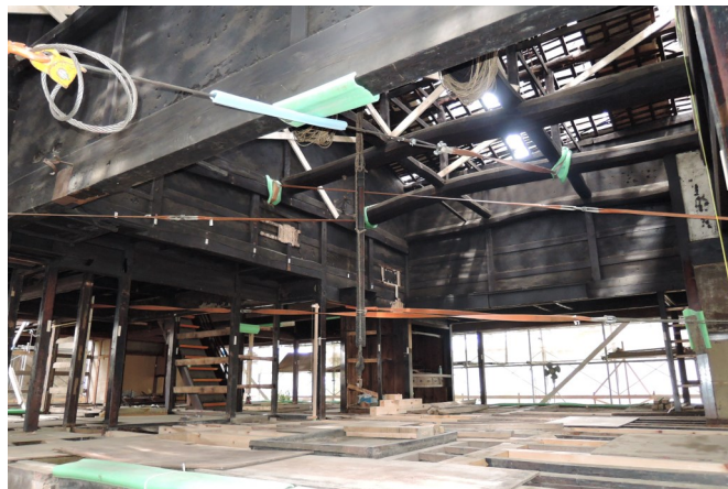
揚げ方の復旧をした後、建物の歪みを直していきます。
