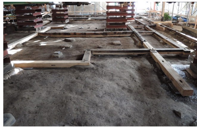
土台は腐朽の状況に合わせて補修または取替を行いました。
