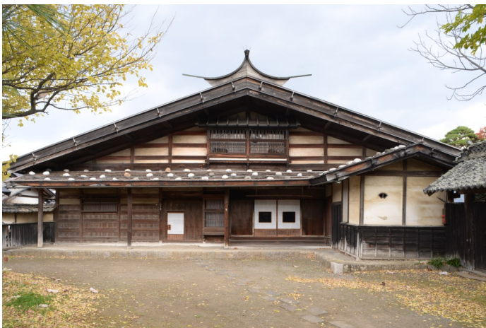
修理前主屋正面
