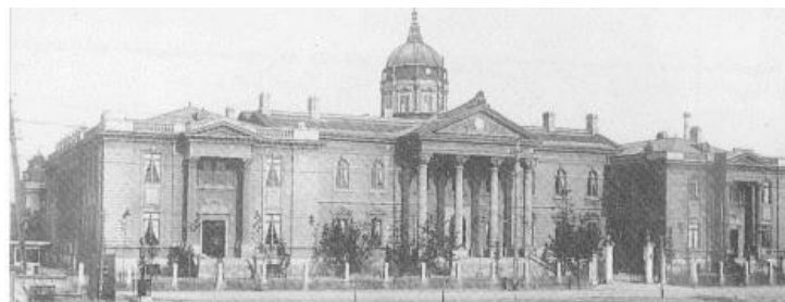
16 図 旧大阪工業奨励館（増築後の旧府庁建物）
